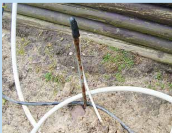
Korrekt: Jordspyd skal være sat i jorden af hensyn til jordforbindelse
